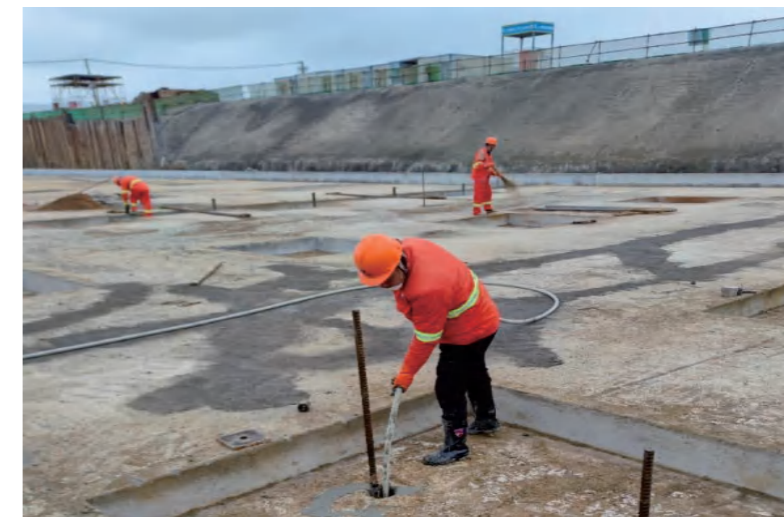
红莲湖未来学校地下室预应力抗浮锚杆工程
