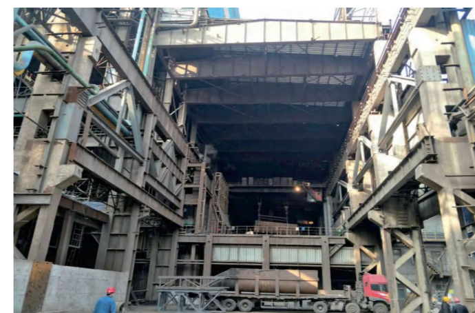
山西高义钢铁厂炼钢厂房某跨结构
