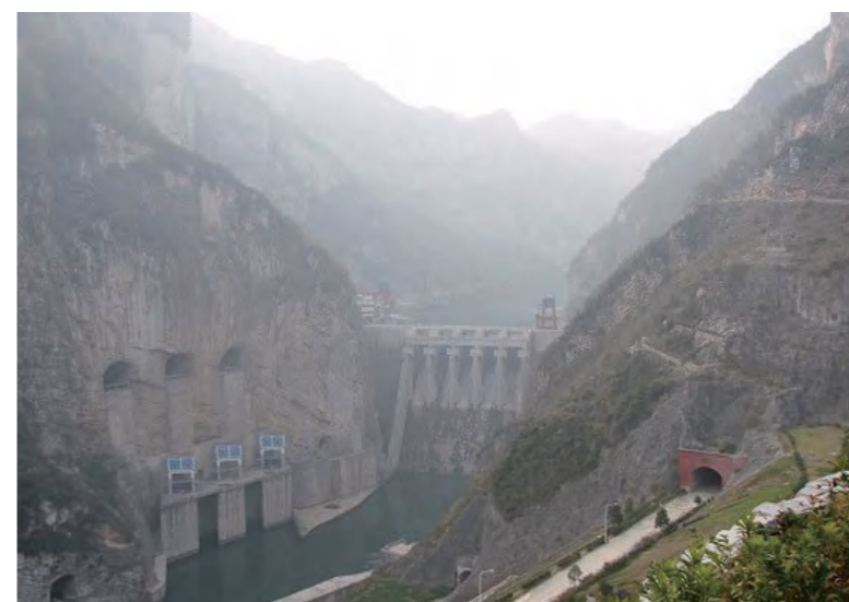
西洱河大坝闸墩弧门支座牛腿加固工程
