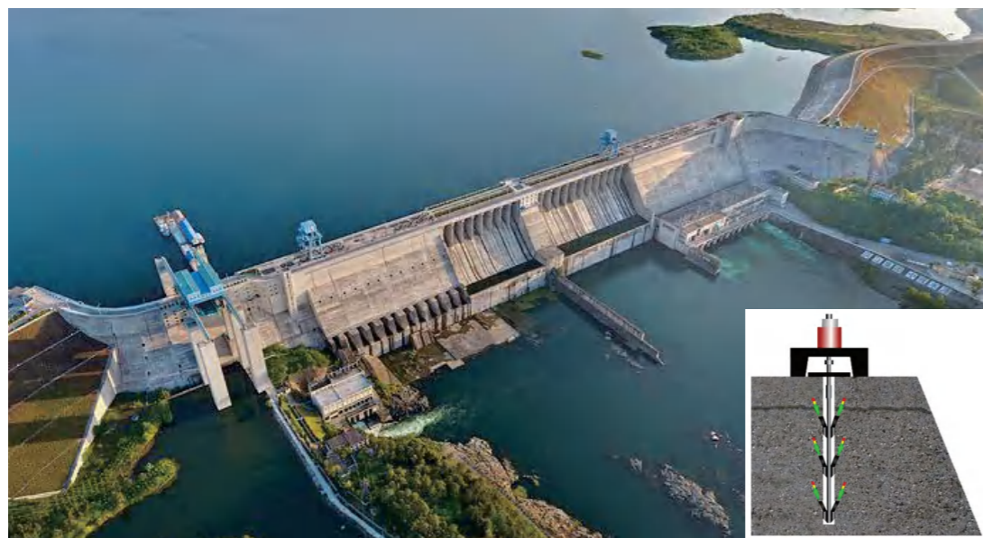
丹江口大坝加高加固工程(获水力发电科学技术特等奖)
