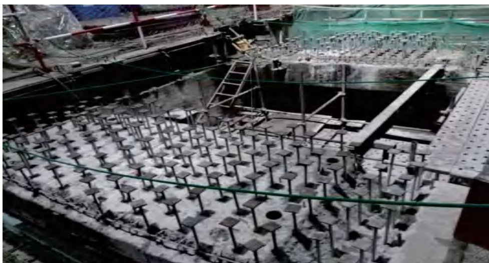
孟加拉国古拉绍电厂汽机基础二次灌浆层拉结锚固工程
