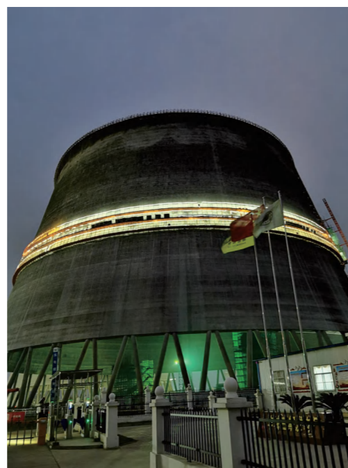
丰城电厂冷却塔加固工程
