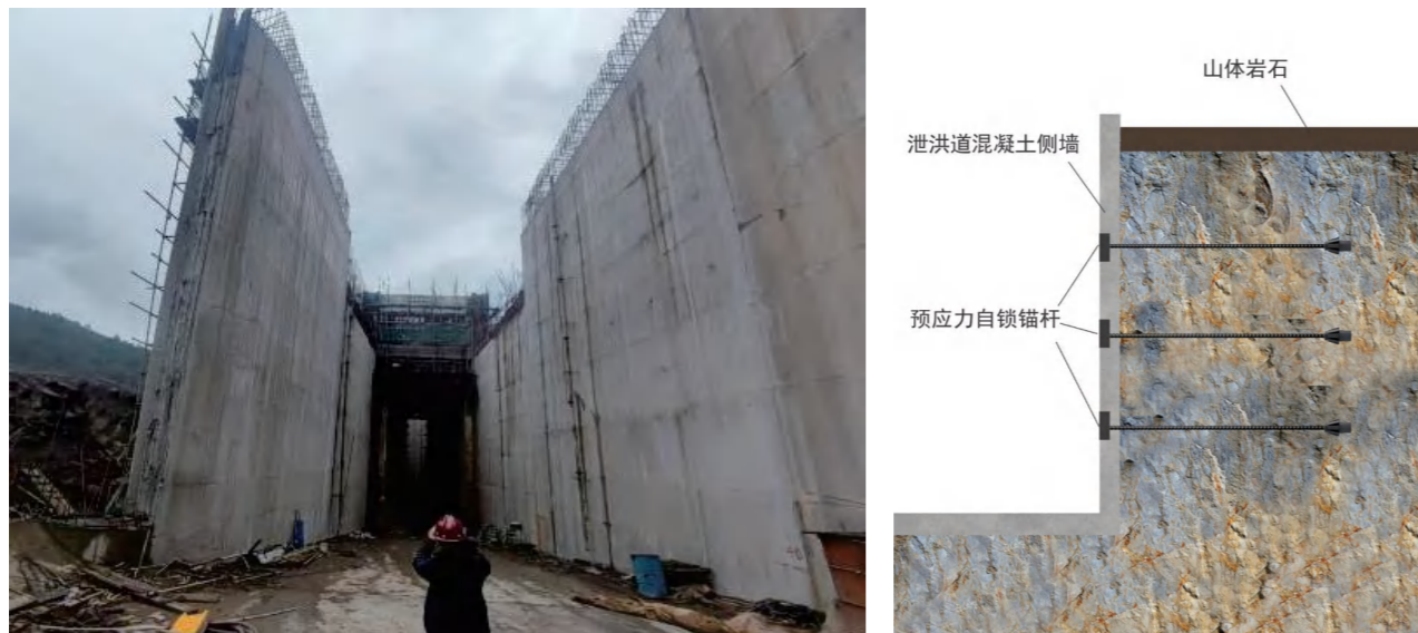
贵州桐梓县某泄洪道侧墙锚固工程
