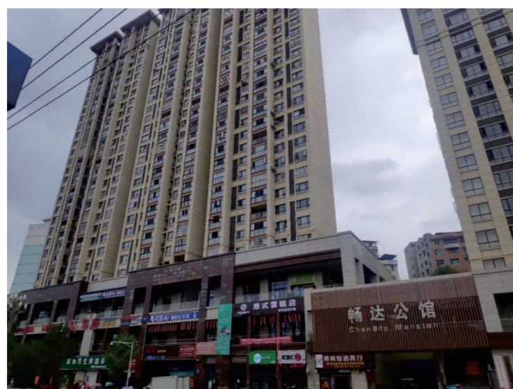
贵州凯里畅达公馆地下室抗浮应急处理工程
