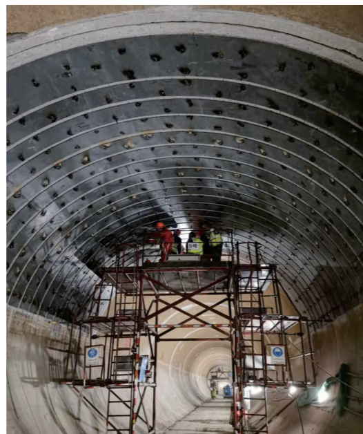
隧洞内衬钢板采用自锁锚杆锚固
