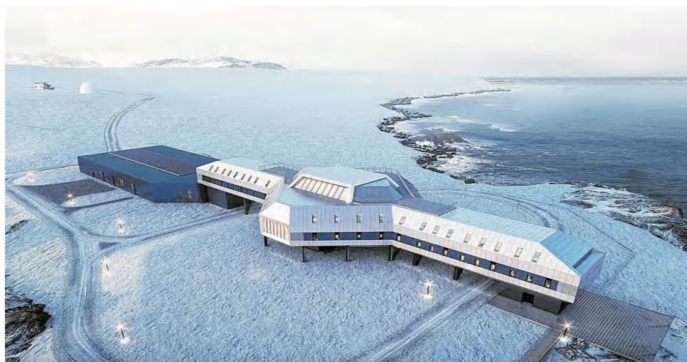
南极营房锚固-中国第五座科考站秦岭站
