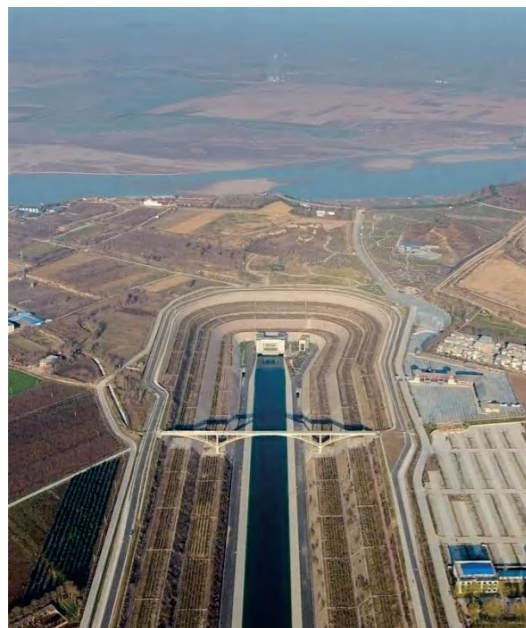
穿黄隧洞粘钢加固工程
