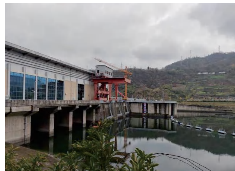
十堰小漩水电站闸墩预应力加固工程
