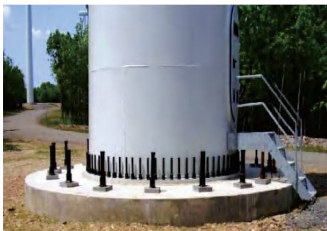
风机基础采用预应力锚索锚固
