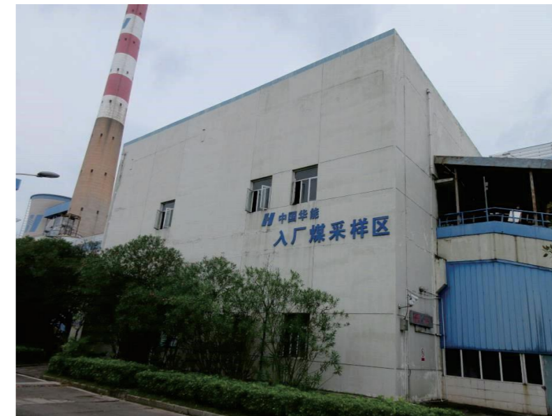
瑞金电厂转运站改造工程
