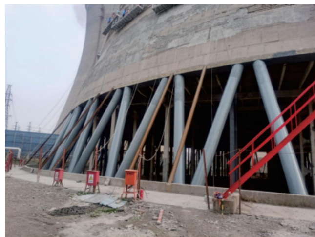
人字柱混凝土加大截面加固
