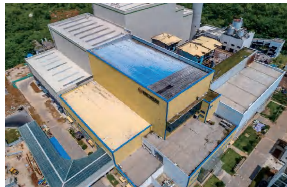
皖能垃圾发电厂4号炉项目一期垃圾厂房加固改造工程
