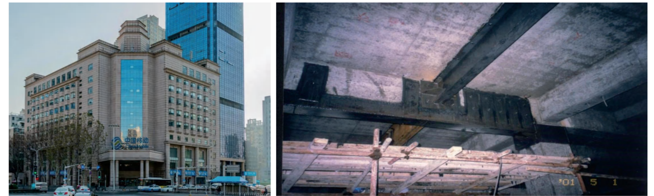
中国移动通信集团湖北移动通信办公大楼加固改造工程
