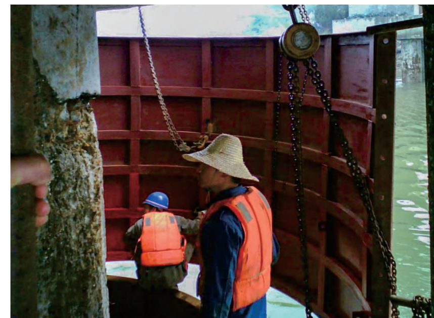
宁德八座跨海大桥水下桩基修复
