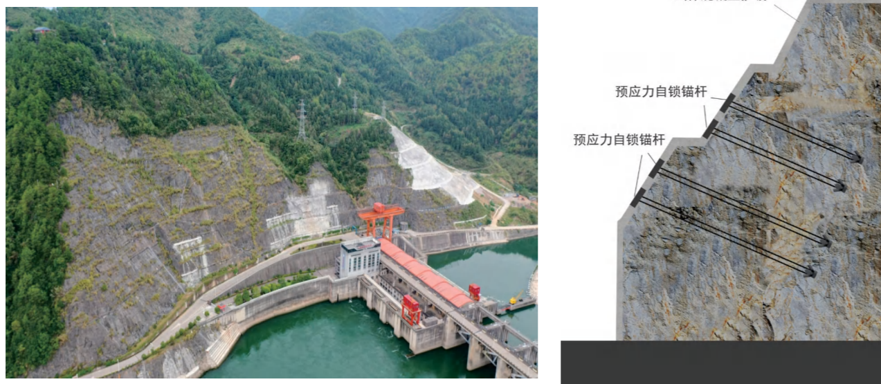
湖南铜湾水电站右岸边坡加固工程
